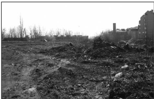
Abb. 100 Stettin – Züllchow (ehem. Anstaltsgelände)
