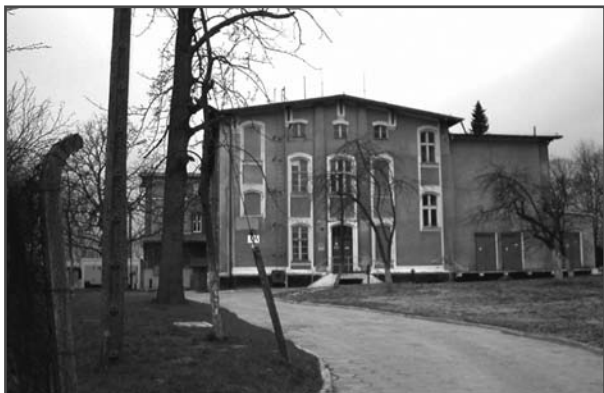
Abb. 97 Stettin – Warsow (ehem. Zweiganstalt)
