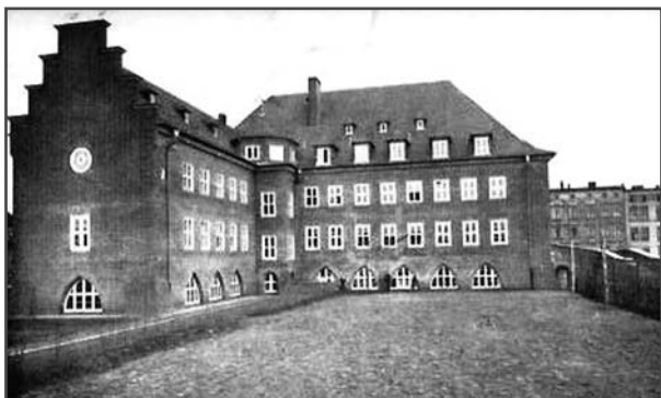
Abb. 102 Stettin – Bethesda (ehem. Werkstattgebäude)
