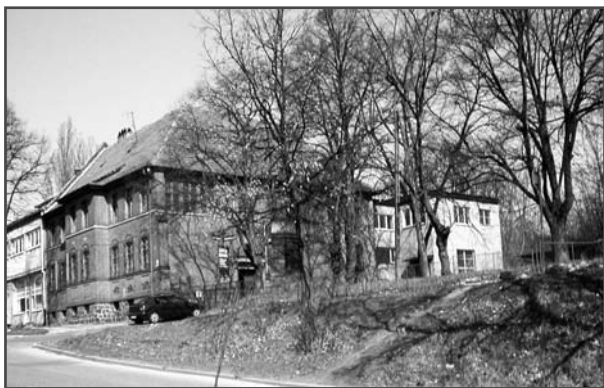
Abb. 98 Stettin – Züllchow (ehem. Pfarr- und Gemeindehaus)
